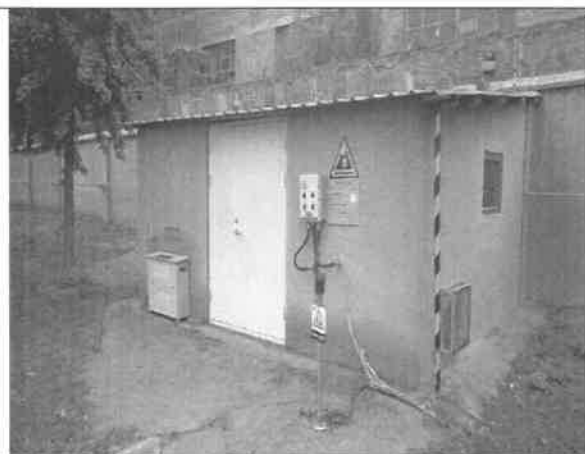
危险废物贮存间
