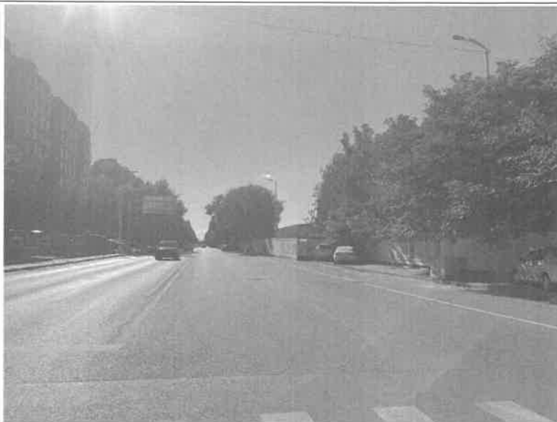
万盛北街与日新路交叉口管道起点施工后
