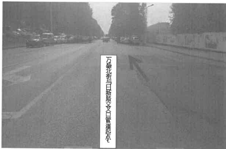
万盛北街与日新路交叉口管道起点施工前
