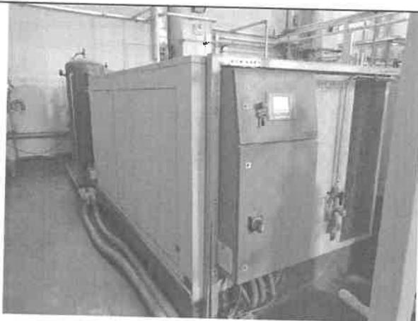
压缩机采取了隔音减震措施
